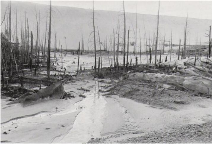
*Bild 9: Deponie der Uranverarbeitung in Stanrock Tailings (Ontario, Kanada). Hier wurden mehr als 100 Millionen Tonnen abgeladen. Der weiße Sand im Hintergrund stammt vom Vermahlen des uranhaltigen Erzes.*
